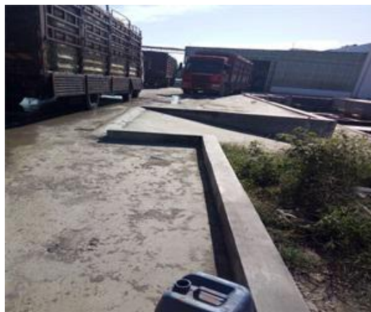
图 3 污水站北侧围堰
